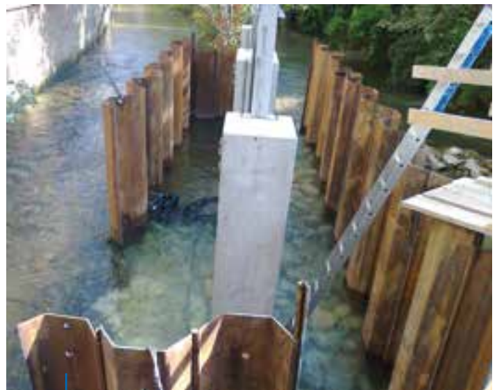
Hochwasserschutz Kleine Blau © EBU
