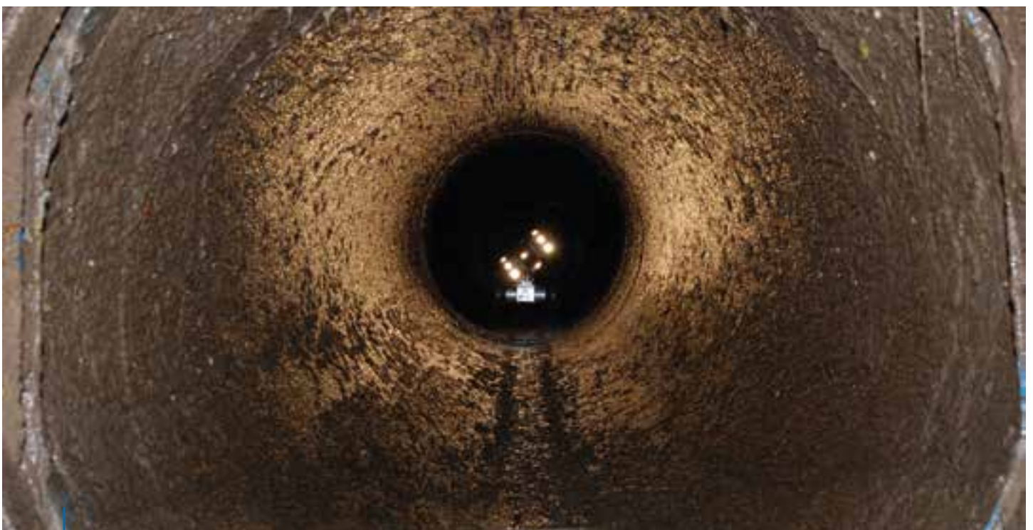
Kamerabefahrung im Kanal © EBU
