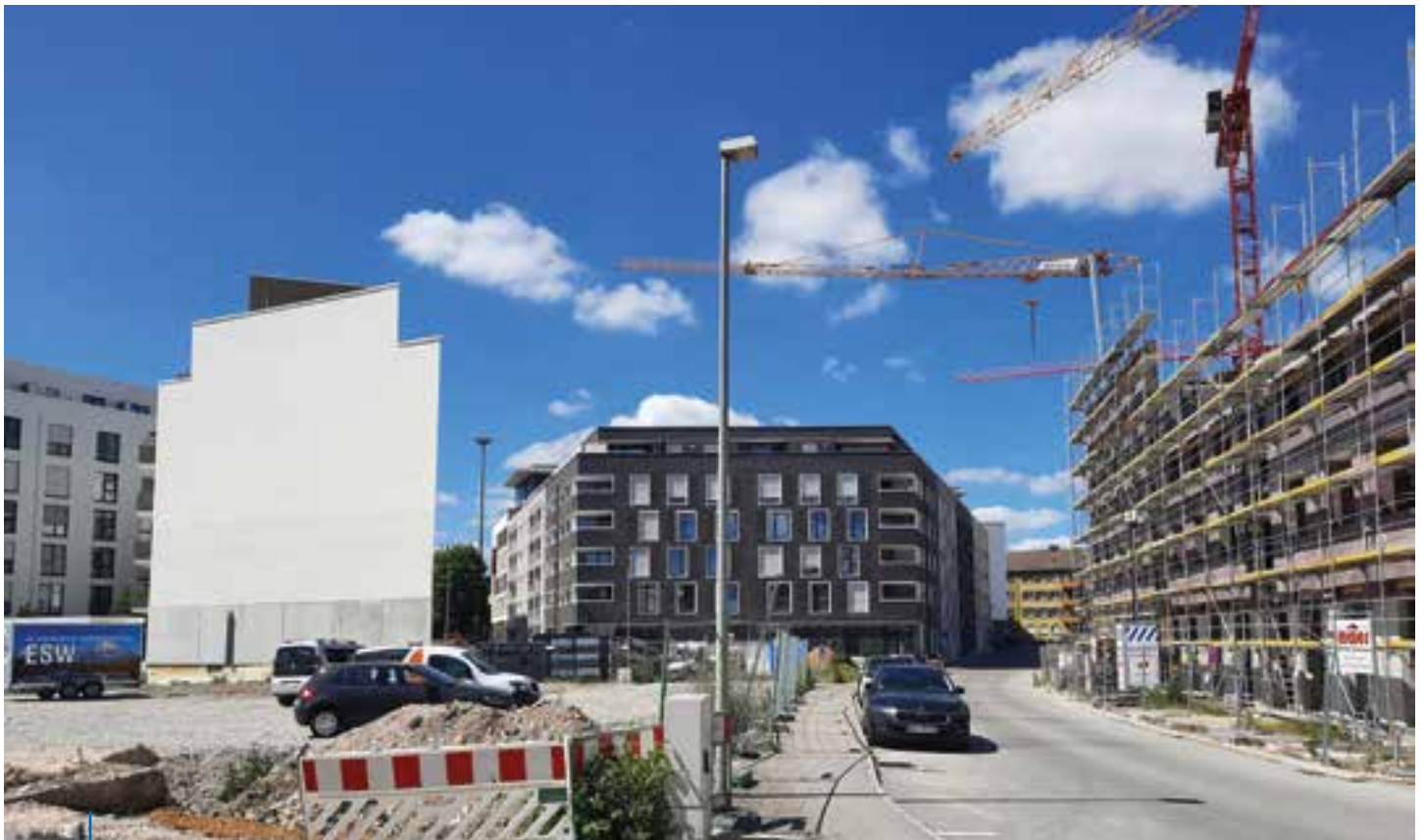
Im Bau: künftiger Stadtplatz im Quartier „Dichterviertel Nord“ © Sanierungstreuhand
