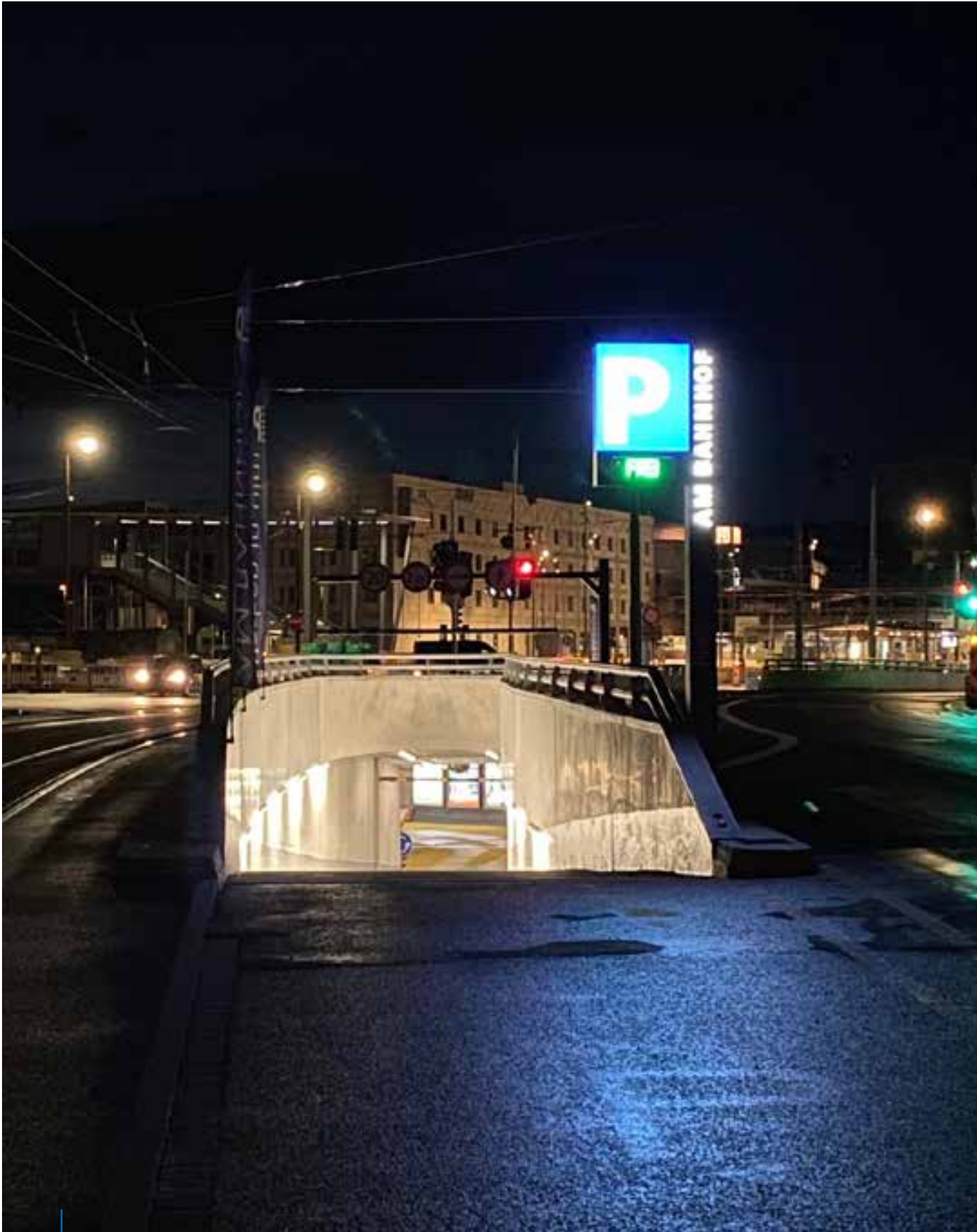
Parkhaus Am Bahnhof, Einfahrt Süd © Ulmer Parkbetriebs-Gesellschaft mbH
