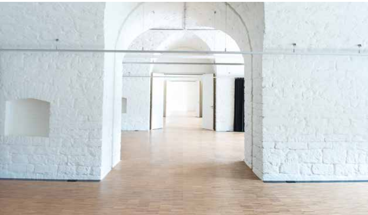
Bereits sanierte Innenräume der Wilhelmsburg
