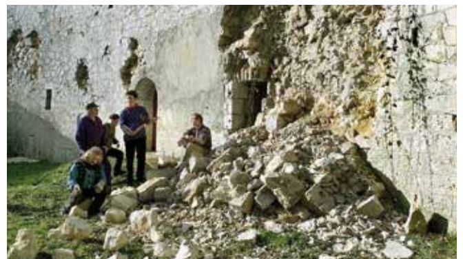
Sanierungsarbeiten des Förderkreis Bundesfestung e. V.
