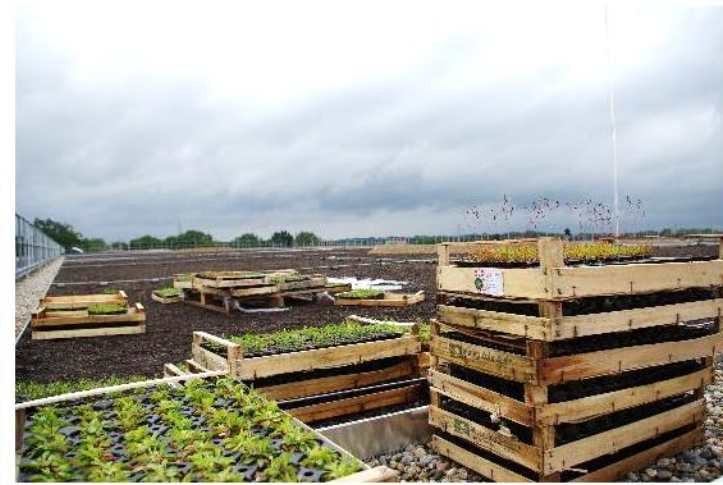
Abb.: Dach Parkhausneubau Klinikum Braunschweig Fotos: Henri Greil
