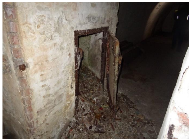
Untere Öffnung des Lüftungsschachts, der mittig im Hof mündet und dort durch ein Gitter abgedeckt ist.
