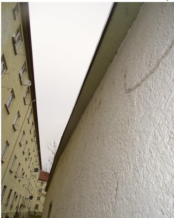
Dto., hier auf der Westseite der Garage.
