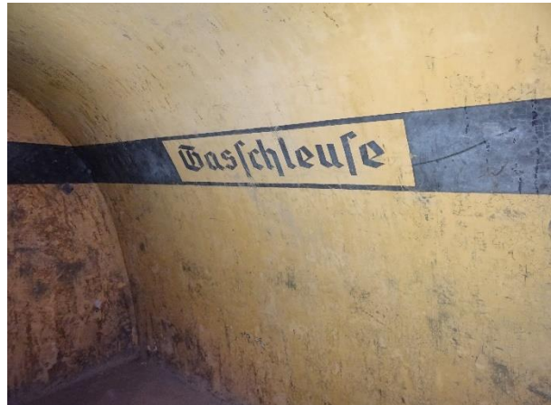
Am Südende war die „Gasschleuse“.
