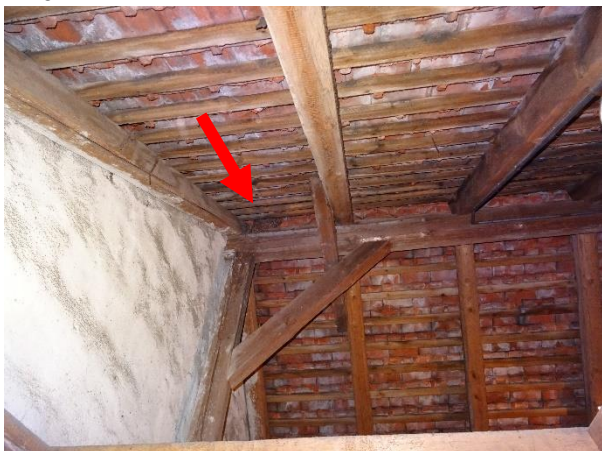
Einziges Nest, sehr wahrscheinlich eines Mauerseglers, unter einem Firstziegel.
