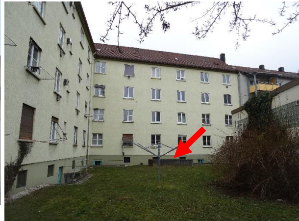
Rückseite Umlandstr. 8 (links) und Söflinger Straße. Pfeil: Eingang in den Bunker
