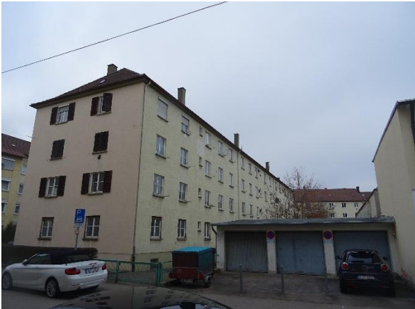
Dto., Rückseite; rechts die Garagen, Zufahrt von der Gneisenaustraße aus.
