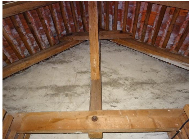
Dto., anderer Dachboden.
