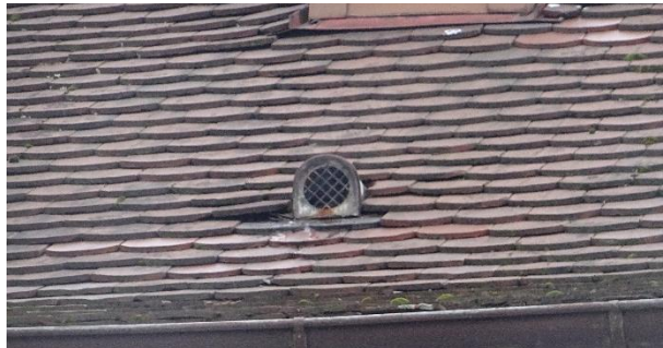
Die Lüfterziegel sind vergittert.
