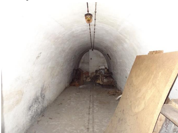
Der Innenraum ist Tunnel-ähnlich; die Wände sind glatt, die Decke ist gerundet.
