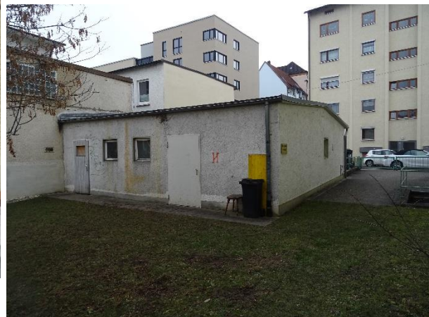
Garagen, Rückseite mit Abstellräumen, vom Hinterhof aus gesehen. Der zweite Eingang des Bunkers befindet sich innen in diesen Räumen.
