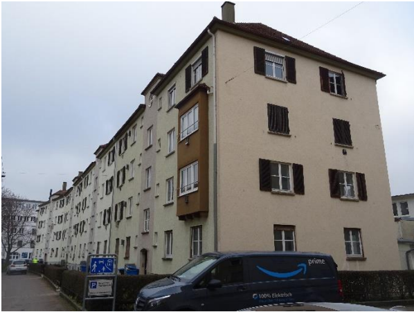
Umlandstr. 2-8, Vorderseite, Blick von Süden. Im EG Jalousien, im 1. Stock aufwärts Holz-Fensterläden.
