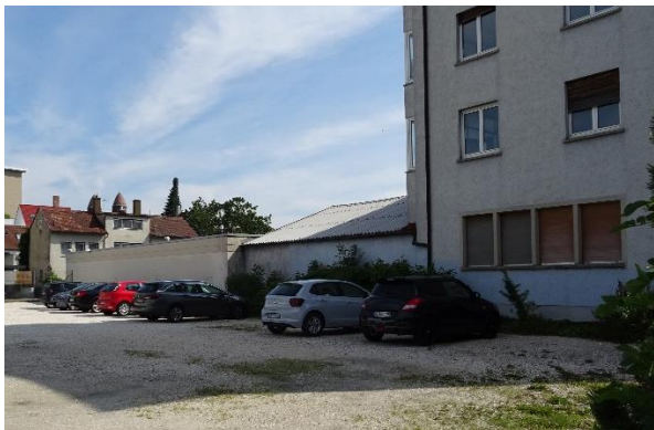
Mittel- und Rückgebäude von Südwesten.
