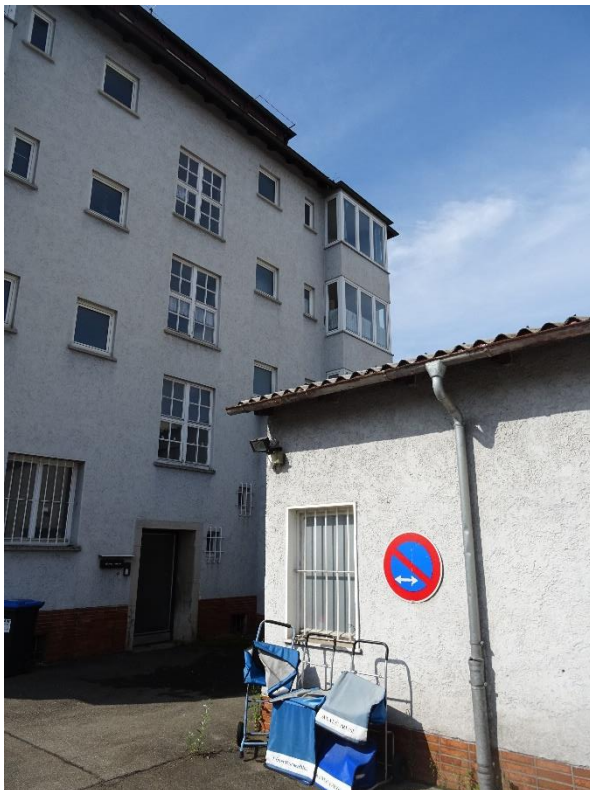
... und Westteil; rechts schon das Mittelgebäude.
