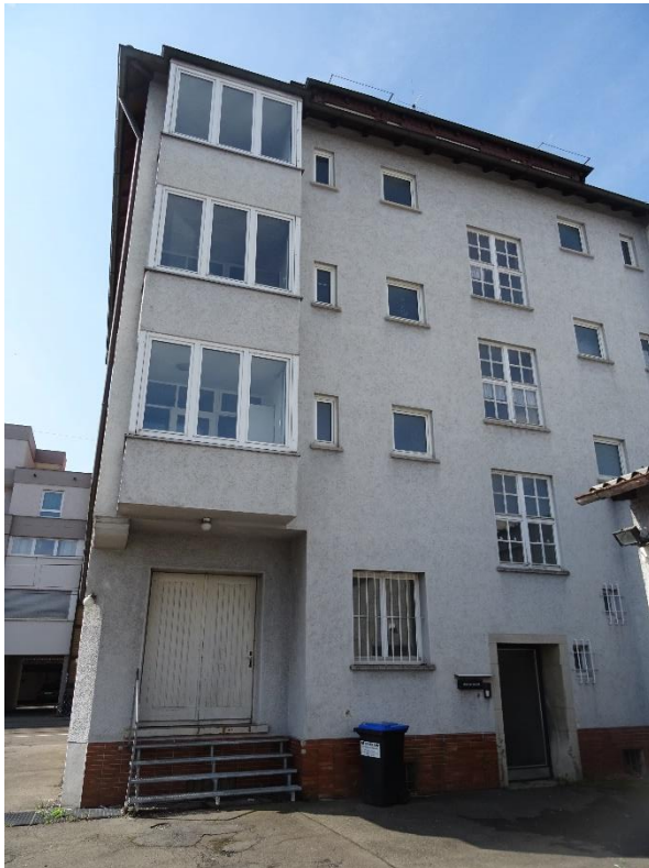
Nordseite des Hauptgebäudes, Ostteil ...
