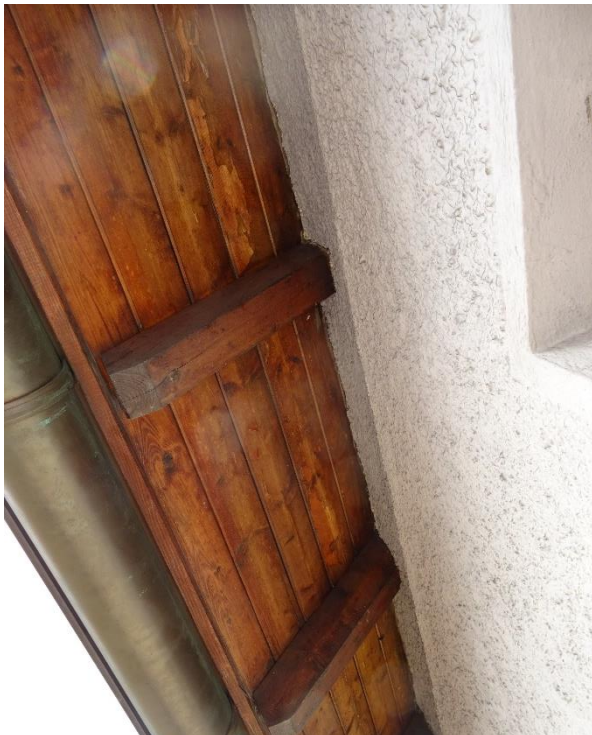
Die Dachüberstände waren sauber und spaltenlos verarbeitet; ohne Schwalben- oder Mauersegler-Nester.
