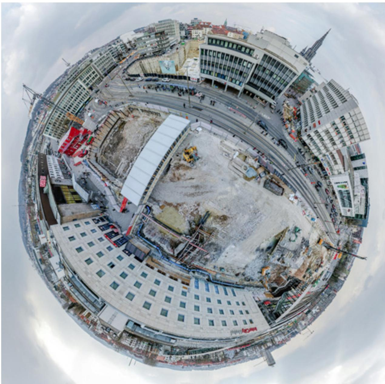
Von den geplanten dreizehn Bauphasen für das Parkhaus Am Bahnhof und die Bahnhofspassage sind seit Baustart im März 2017 bereits fünf Phasen realisiert worden. Bis Oktober 2018 wird mit Hochdruck auch samstags gearbeitet, damit die Teildeckel über die Baugrube gelegt werden können und anschließend das ÖPNV-Provisorium hergestellt werden kann.
