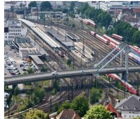
Sanierung Brückenbauwerke 15 Mio. €
