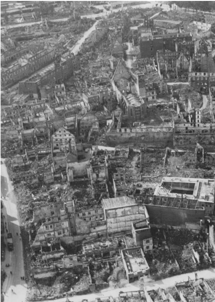
Ulm in Trümmern: Blick vom Münster auf Pfauen-, Wengen- und Ulmergasse sowie die Bahnhofstraße (1945)
