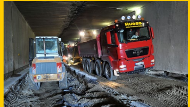
Bodenaustausch während der Tunnelsanierung
