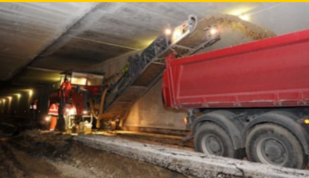
Bodenaustausch während der Tunnelsanierung
