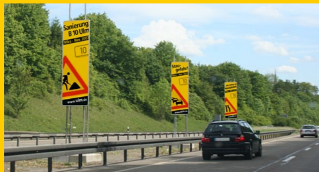
Hinweisschilder an der B 10 in Richtung Süden
