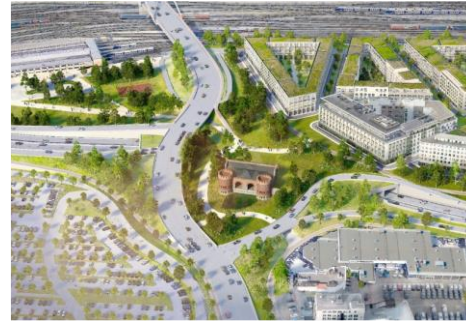
Blaubeurer Tor- Tunnel/ Wallstraßenbrücke
