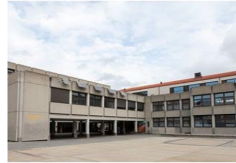
Sanierung von Schulgebäuden
