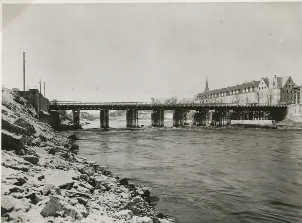
Provisorische Gänstorbrücke ca 1946 (StA Ulm, G 7/3.1 4600 Nr. 14)
