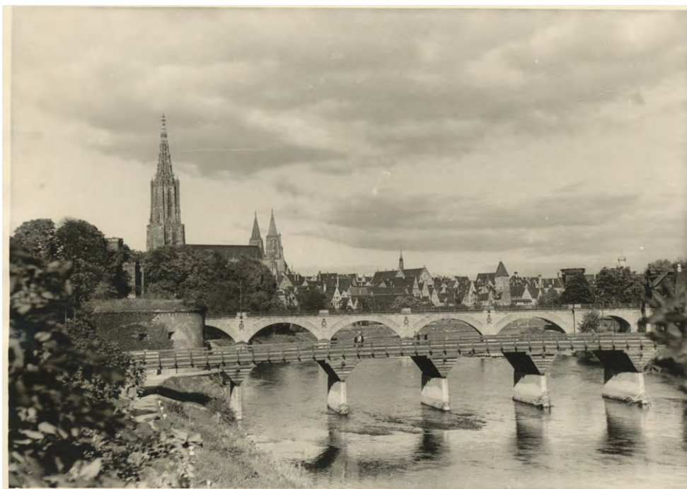
Schillerbrücke im Jahr 1943 (StA Ulm, G 7/2.1 Donaufront)
