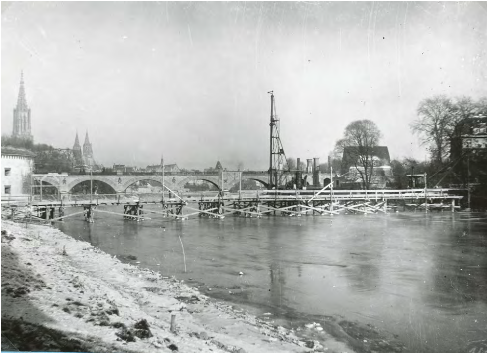
Schillerbrücke im Bau 1927 (StA Ulm, G 7/2.1 Donaufront)
