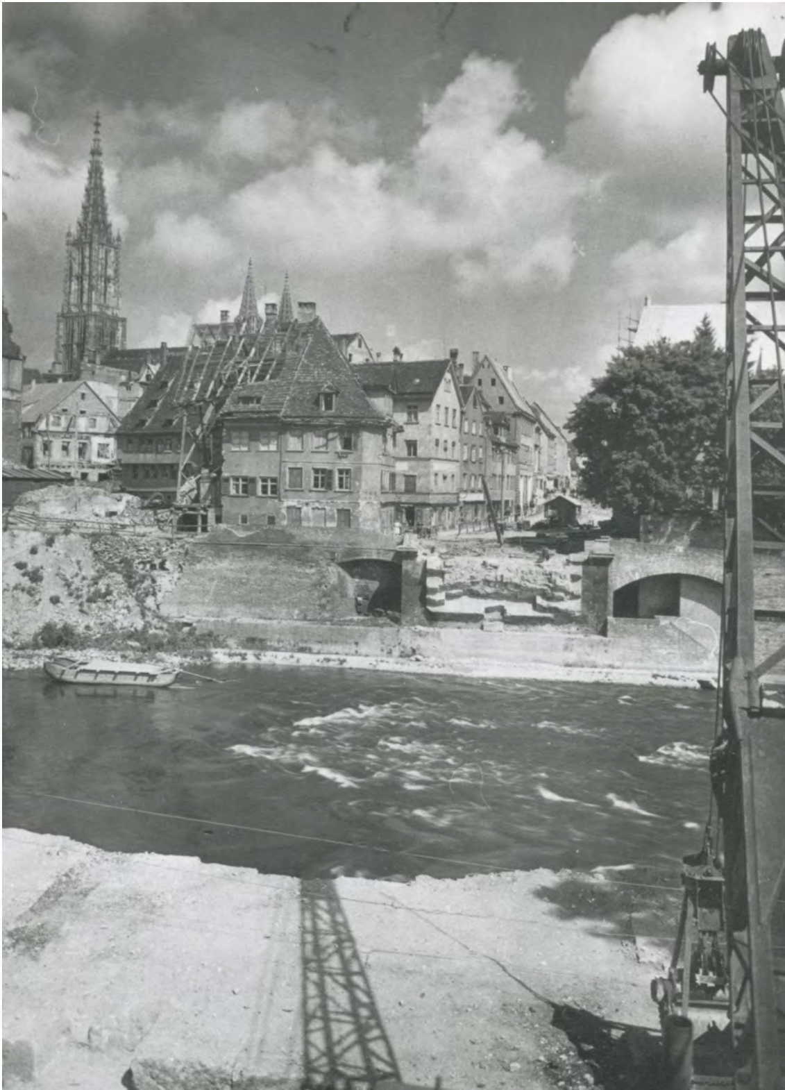
Zerstörte Herdbrücke vor dem Wiederaufbau 1947. (StA Ulm G 7/2.2 Donaufont)
