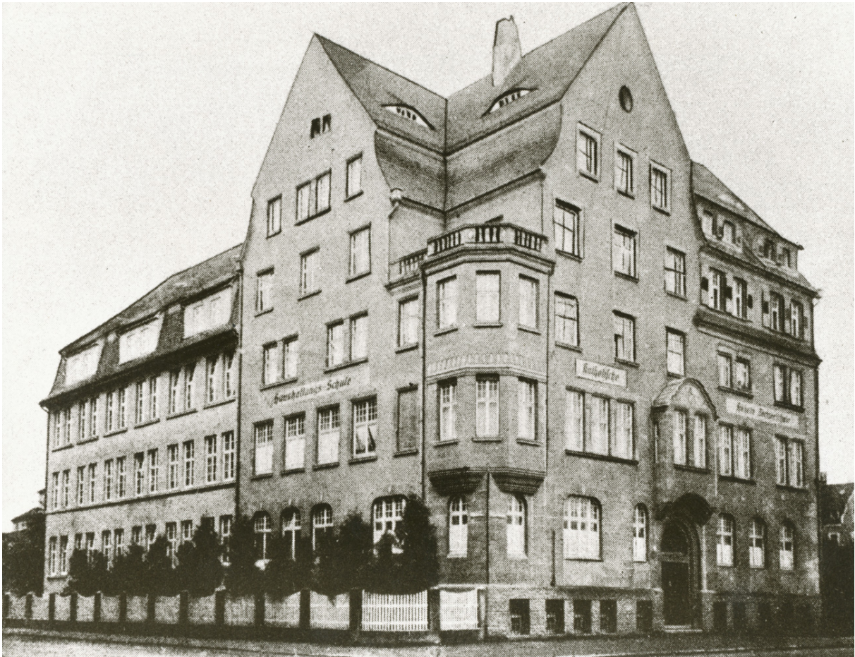
zuvor Gebäude des Reform-Pädagogium. Linker Gebäudeflügel nachträglicher Erweiterungsbau von 1926 für das Internat. (Privat Schwesternkonvent St. Hildegard)
