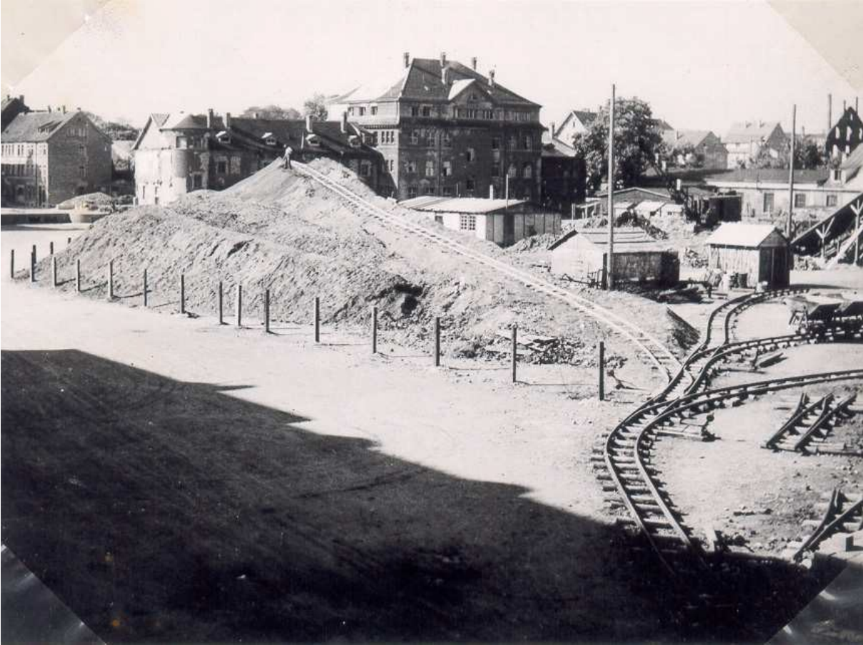
Material 7: Blick auf die Trümmeraufbereitungsanlage auf dem Gelände der ehemaligen Karlskaserne, Ecke Syrlinstraße/Karlstraße, 1949 (StA Ulm, G 7/3.1 1949.6.15 Nr. 2b)
