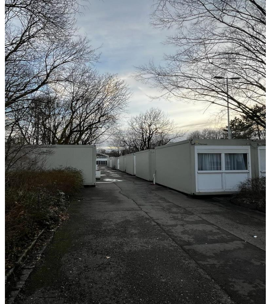
Bild: Container Wielandstr. - nahe Stadion
