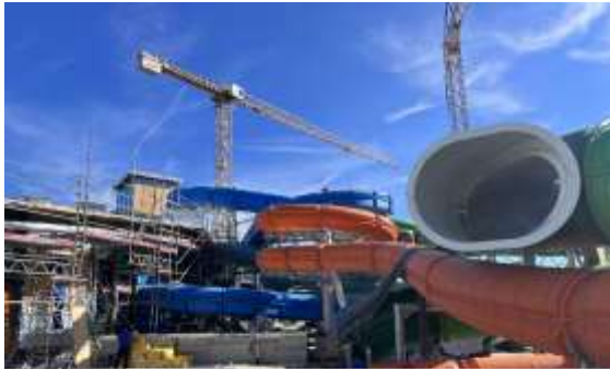
Donaubad, Sanierung Rutschenanlage
